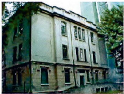
*Saída de Emergência, 2002
