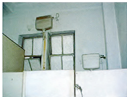
*Banheiro Masculino Térreo, 2002
